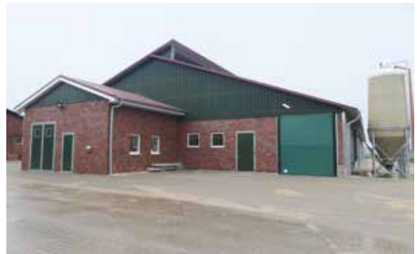
Bezugsfertig: das neue Gebäude
